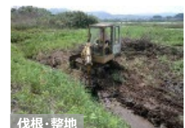
伐根・整地 【粗放的利用のための条件整備】
